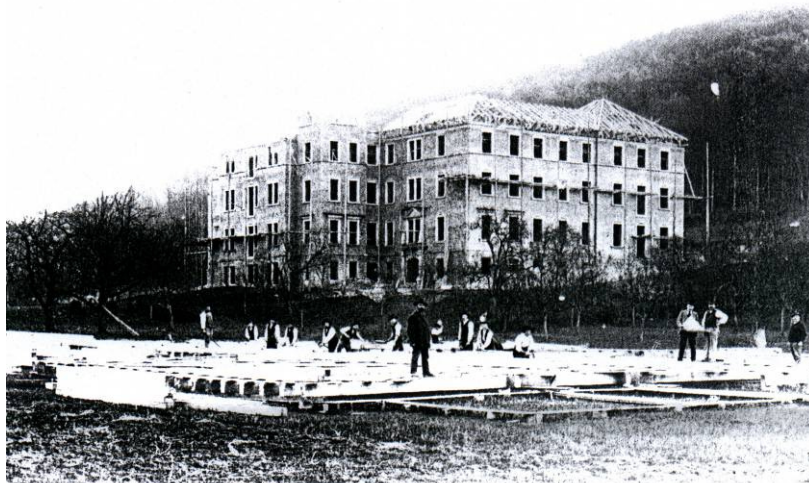
Noch als Baustelle. Aufgenommen ca. 1897. (Foto: Stadtarchiv in Neckargemünd)
